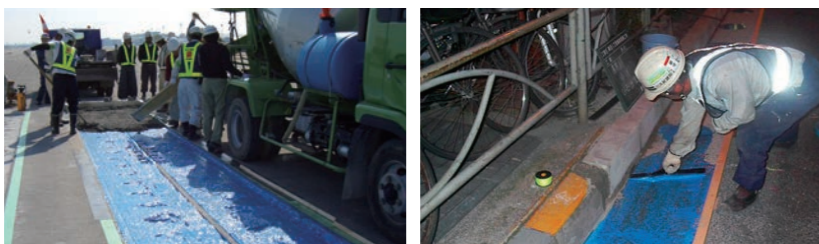
空港用薄層付着オーバーレイ工法 県営名古屋空港(2009年)
