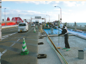
浸透性樹脂の塗布状況
