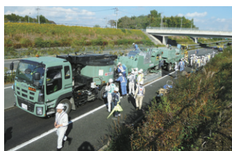
高速道路本線での施工状況
