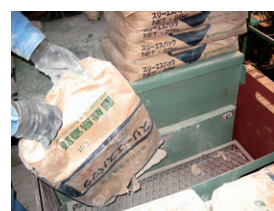
ミキサへのセメント投入状況
