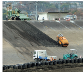
貯水池改修工事での切削状況
