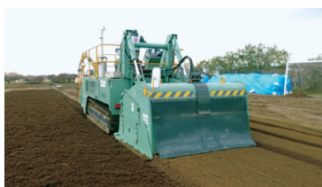
インブルクレイ工法の施工状況
