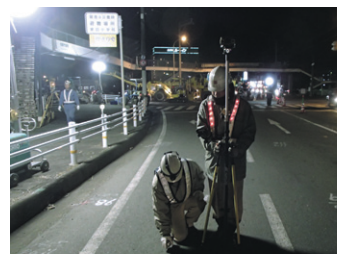
切削深さマーキング作業
