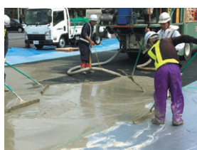
宮島SA施工状況
