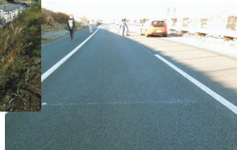
施工2年後の路面状況
