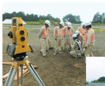
トータルステーションを使った丁張設置
