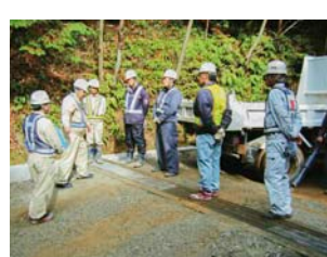
安全パトロールの様子
