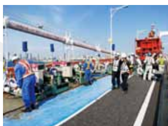
機械によるコンクリートの打設
