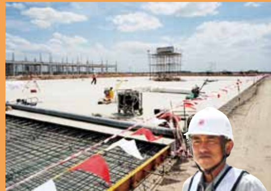
ベトナム工事現場
