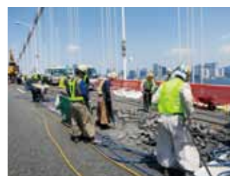
アスファルト舗装の人力取り壊し
