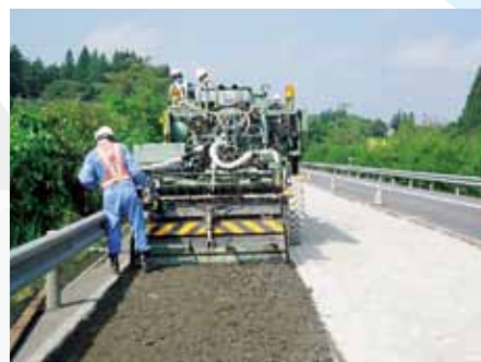
高速道路上での施工状況
