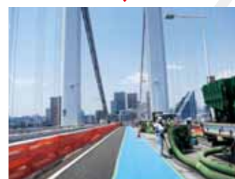
既設鋼床版の研掃
