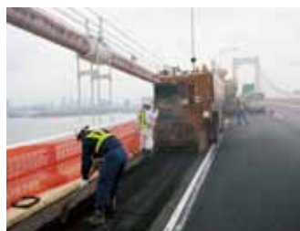
アスファルト舗装の機械切削
