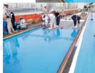
高耐久型エポキシ接着剤(KSボンド)塗布
