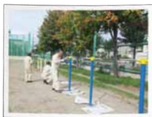
鉄棒塗装作業状況
