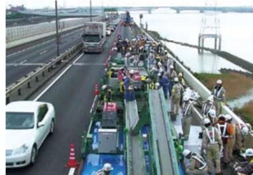
鋼床版上SFRC(鋼繊維補強コンクリート)補強工法
