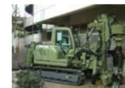
狭隘箇所での施工状況(上空3.0m、離隔0.5m)
