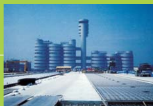
1993年 東京国際空港エプロン舗装等工事(その2)
