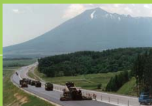
1982年 東北自動車道松尾舗装工事
