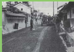
1959年 富田林舗装工事
