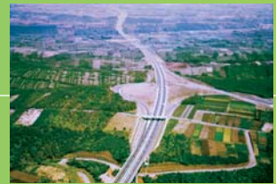
1968年 東名高速道路厚木～大和間舗装工事
