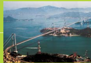
1999年 来島大橋舗装工事
