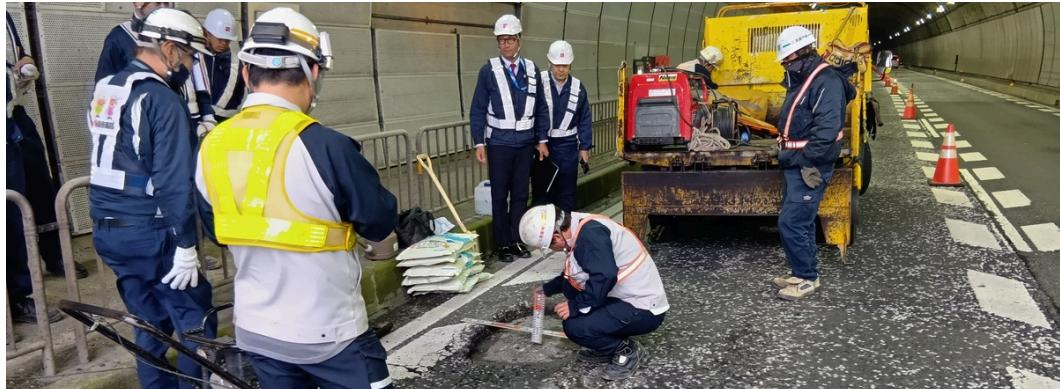
本セッションは、直轄国道における道路維持管理の高度化を目的に、職員が新技术・新材料を現場で「見て・触れて・確認する」実践的な取組として実施したものです。試験施工は、国道163号 清滝トンネル内の舗装損傷箇所において行い、鹿島道路（株）の協力のもと、以下の補修材を用いて施工を実施しました。
