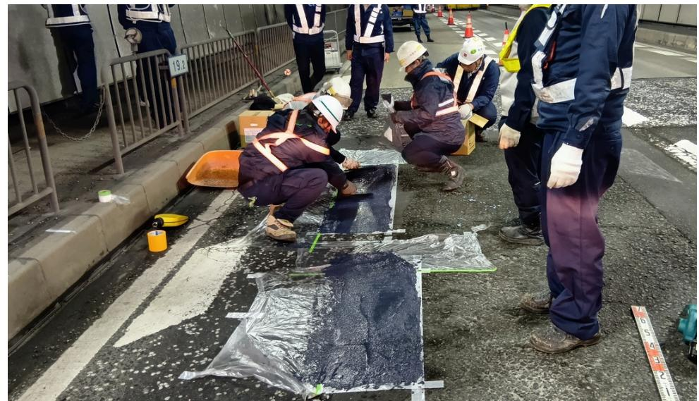
施工にあたっては、既設舗装の状況に応じて補修材を使い分け、施工手順、施工時間、施工性、交通への影響などを確認しました。
