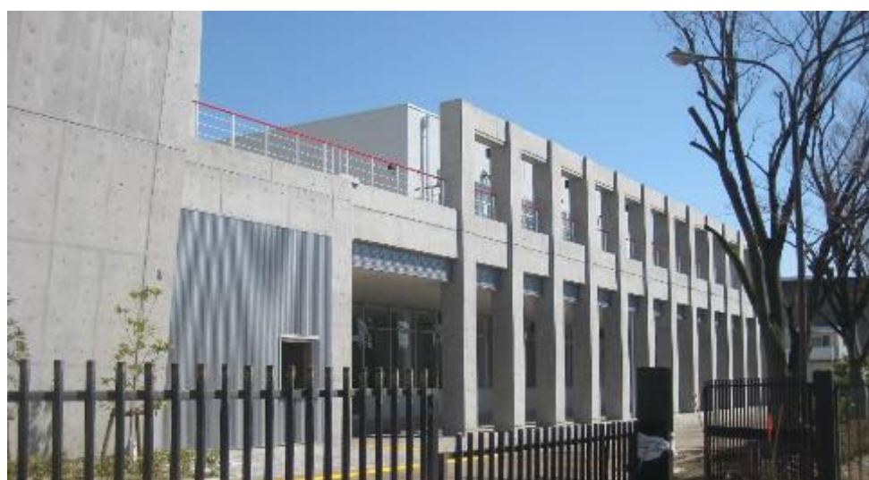
外観_アリーナ棟
