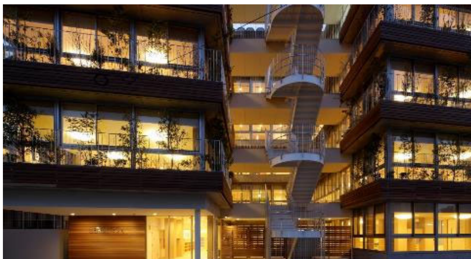
外観_玄関ポーチ
