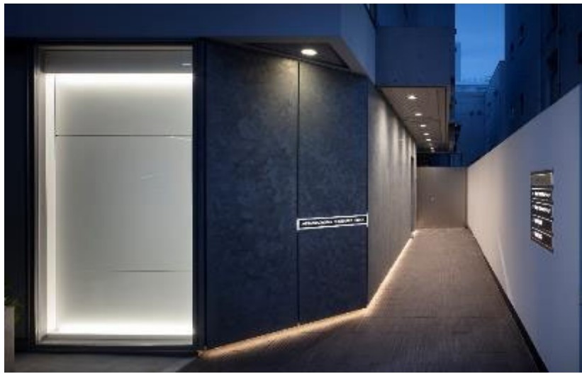
外観_エントランス
