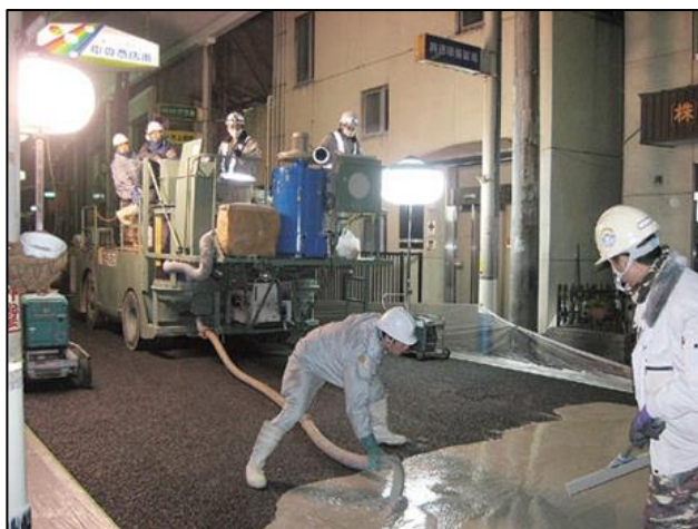
浸透作業状況
