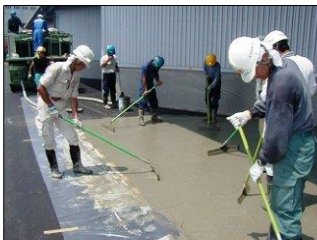
浸透作業状況
