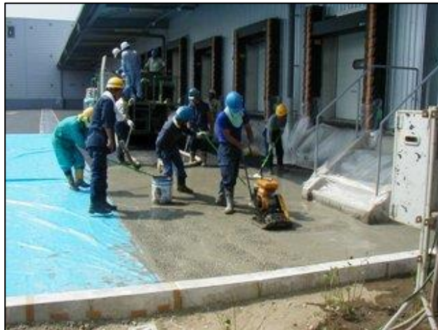
浸透作業状況
