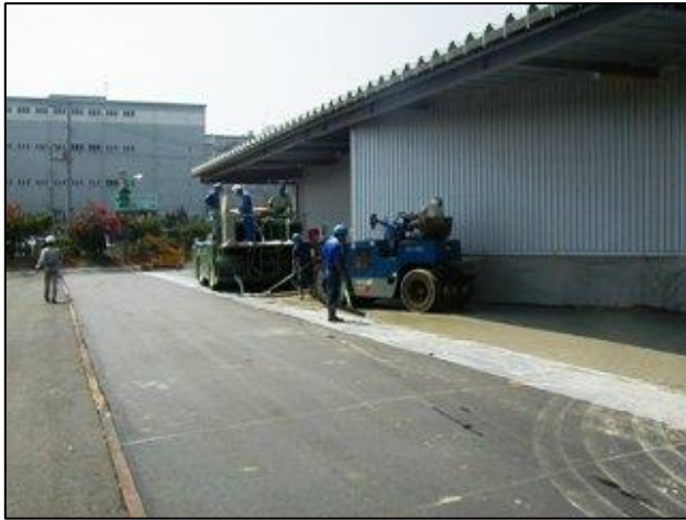
浸透作業状況
