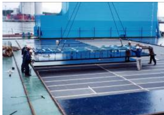
摩擦増大用アスファルトマット敷設状況 （宮崎県 宮崎市 フローティングドック上）
