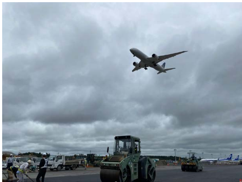
飛行機の真下での施工です！
