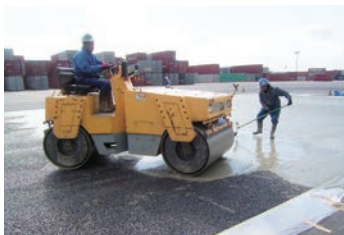
工事規制が長期間確保できる箇所
