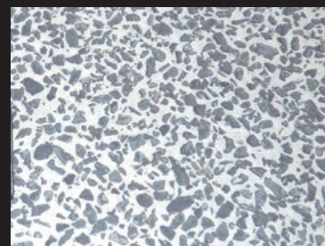
スリーエス舗装表面仕上り
