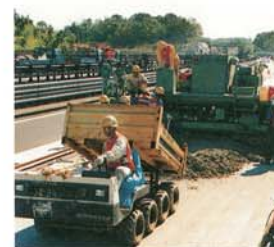
コンクリート打設
