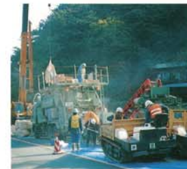
コンクリートの製造・運搬
