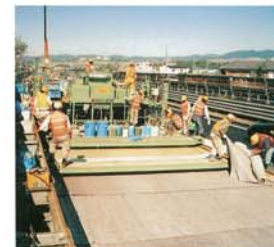
コンクリートの養生
