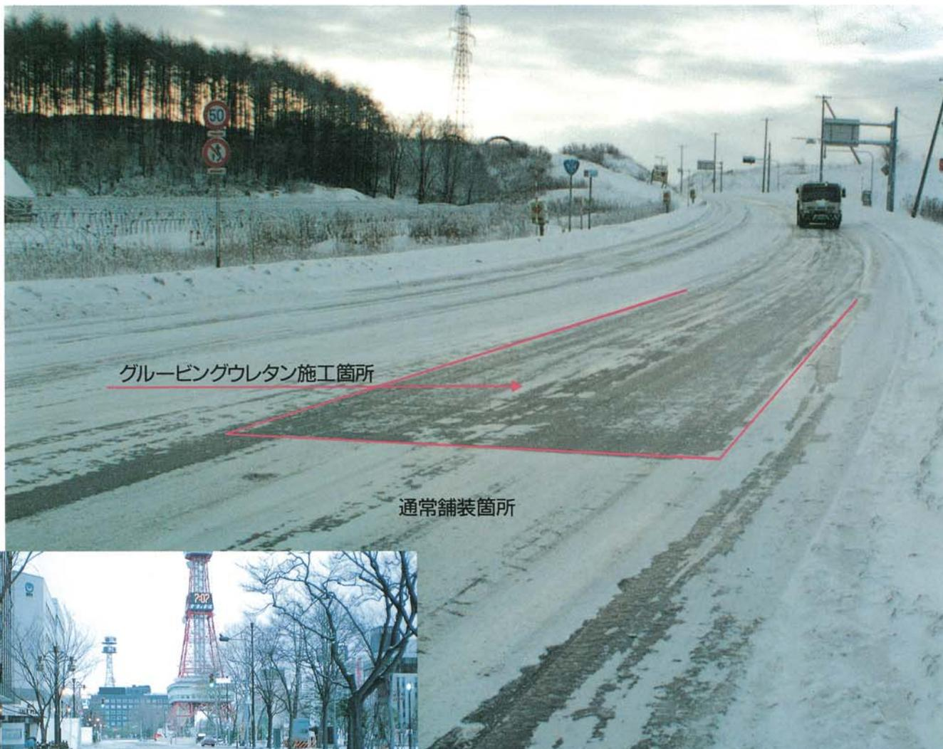
グルーピングウレタン工法は、アスファルト舗装またはコンクリート舗装面にグルーピング（幅6～12mm、深さ6～12mm、間隔25～60mmの溝）を行って、この溝の中に弾性のあるウレタン系樹脂を流し込んで仕上げる路面凍結抑制舗装工法です。
