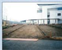
①型枠設置
