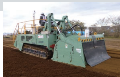
ストーンセパレータによる混合状況
