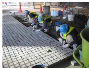
⑥ 自然石の設置（裏面には特殊樹脂スラリーを塗布）
