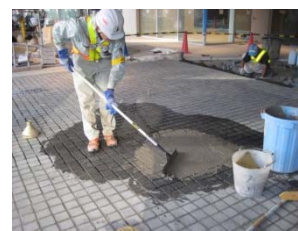
⑦ 特殊樹脂目地モルタルの流し込み
