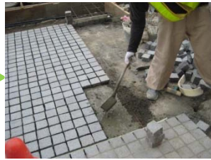
② 基礎コンクリート面への特殊樹脂スラリー塗布
