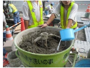
③ 特殊樹脂モルタルの練り混ぜ
