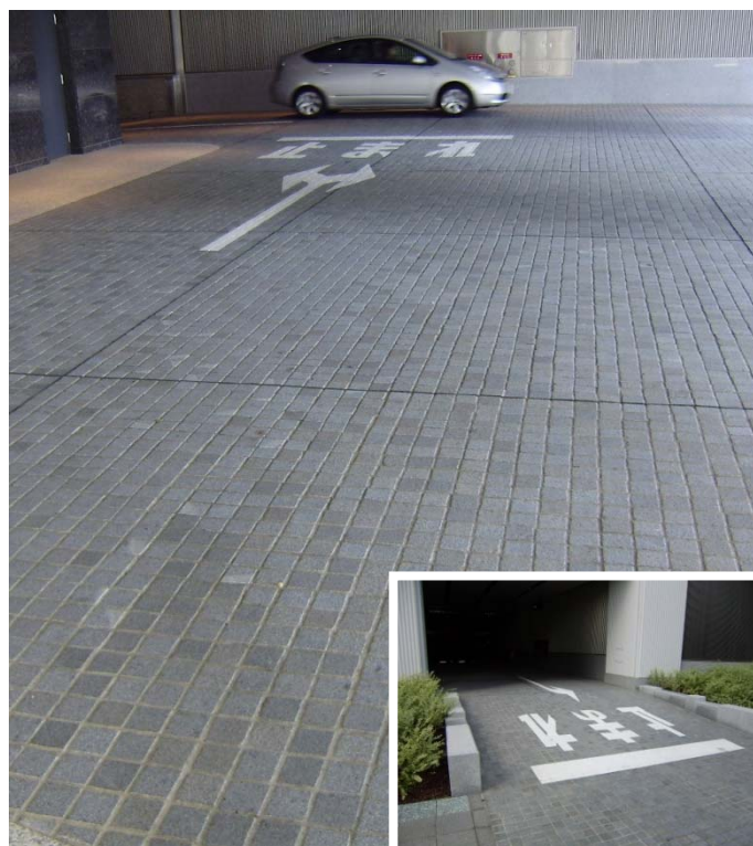
豊洲駅前豊洲フロントビルエントランスおよび地下駐車場入口 平成22年6月施工
