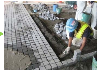
④ 特殊樹脂モルタルの敷き均し
