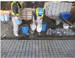
⑤ 敷きモルタル面へ特殊樹脂スラリー塗布
