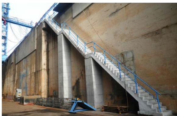
築造後50年近く経た建造ドック階段のリニューアル工事を施工担当、ドック渠底から15m弱の作業足場での人力高所作業、特殊構造物としての階段製作工事として施工精度も施工品質も「高」を求められたが、無事完成し客先へ引き渡し出来た。
