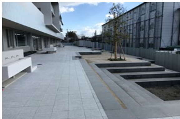
有家小学校外構工事
