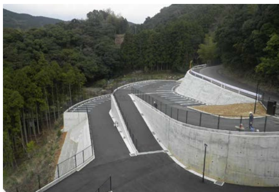
老健施設 (なでしこ荘) 敷地造成工事 長崎特有の斜面地を利用した施設駐車場確保を目的とした敷地造成の為の大型構造物の築造とその舗装工事 土止め擁壁最大高さ H=6.5m
