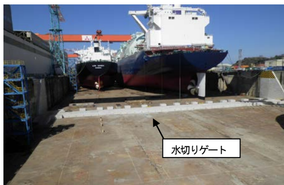
三菱重工業長崎造船所香焼工場の100万tドック内水切りゲート設置用基礎工事、施工幅 W=100m
