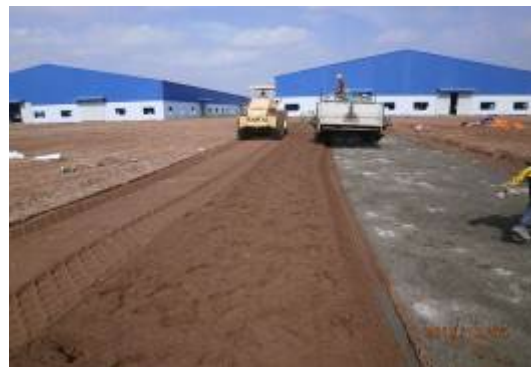
スタビライザーによるセメント改良工事 日系ゼネコンを始め、ローカルゼネコンからも受注しています。 【南部メコンデルタ地区】
