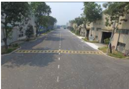
改質アスファルト (SBS) を使用した舗装改修工事 コンクリート舗装の破損がひどく改質アスファルトでの改修工事を行いました。品質・コスト面でも評価を受けました。 【ビンズオン省】
