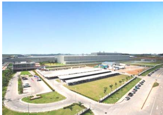
FORD 新工場外構第 1 期工事 当社は造成・地盤改良・舗装・排水・植栽を施工 【ラヨン県ヘマラート工業団地内】
