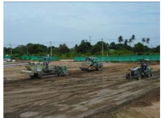
スタビライザを用いたセメント地盤改良工事 軟弱地盤の多いタイでは非常に有効な工法 【チョンブリ県 工場外構工事現場】
