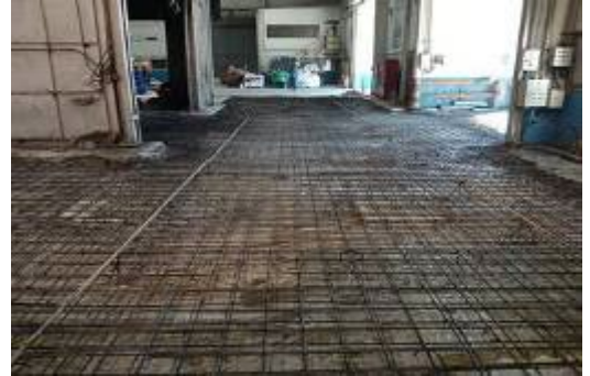
既存工場のスラブ補修工事 沈下によりスラブが破壊し、コンクリートの再打設 【チョンブリ県 ゲートウェイ工業団地内】
