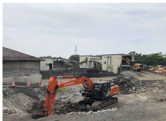
中間処理工場
