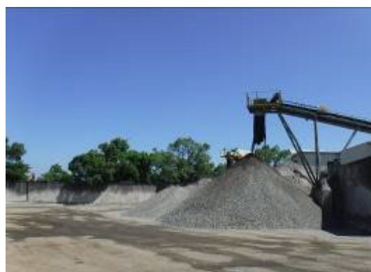
再生製品ストックヤード
