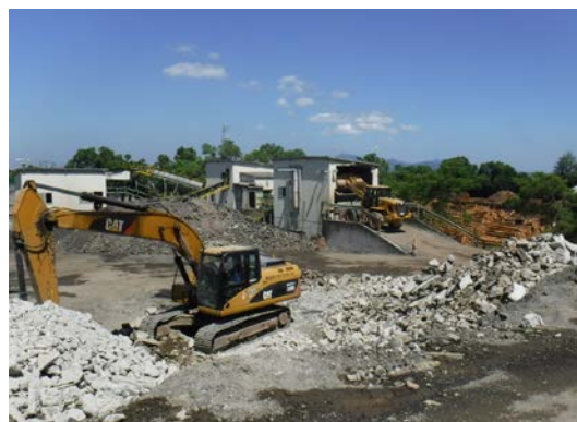
中間処理工場
