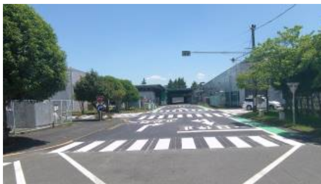
日立製作所厚木工場構内道路工事
