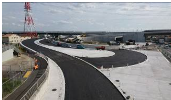
厚木南ICオン・オフランプ工事
