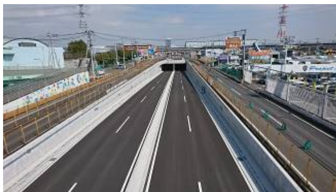
国道129号戸田立体交差工事
