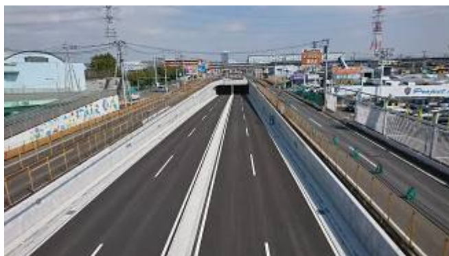
国道129号戸田立体交差工事
