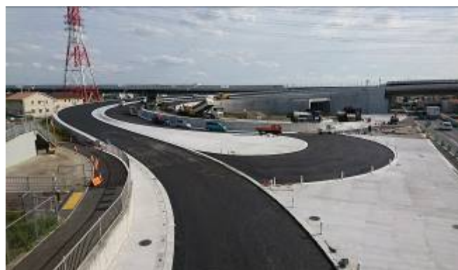
厚木南ICオン・オフランプ工事
