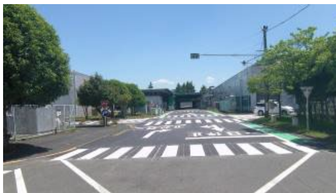
日立製作所厚木工場構内道路工事
