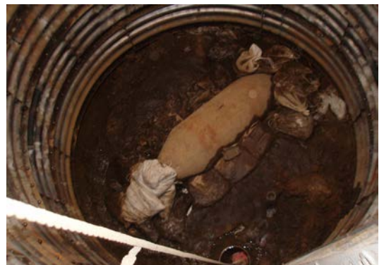
京王線調布駅付近連続立体交差事業で発見した500kg級爆弾 ※探査結果から土留め壁中心位置を決定 (調布市都市整備部 京王電鉄) 【東京都調布市】
