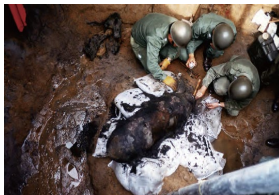
東京都 鉛直磁気探査により発見された250kg爆弾
