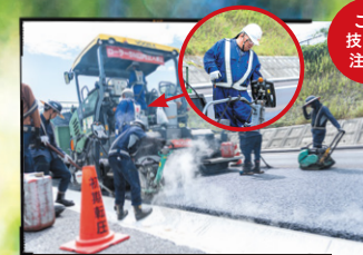
敷均し 現場で確認しながらパネル操作を行う
