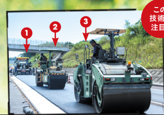
締固め 加熱式振動タイヤローラを含む連続した3台のローラ車で確実に締固める
