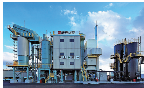
アスファルトプラント
