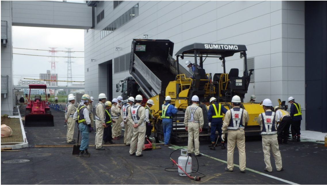
試験施工状況
